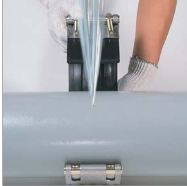
1. ストラブ・クランプを補修箇所巻つけます。
