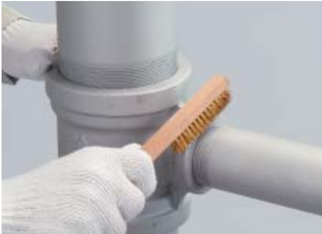
① ネジ部のサビや汚れを除去します。
