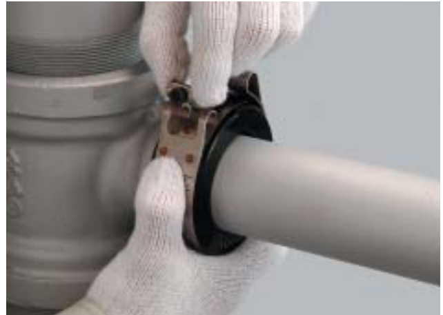
④ 棒状ナットをケーシングに掛けます。
